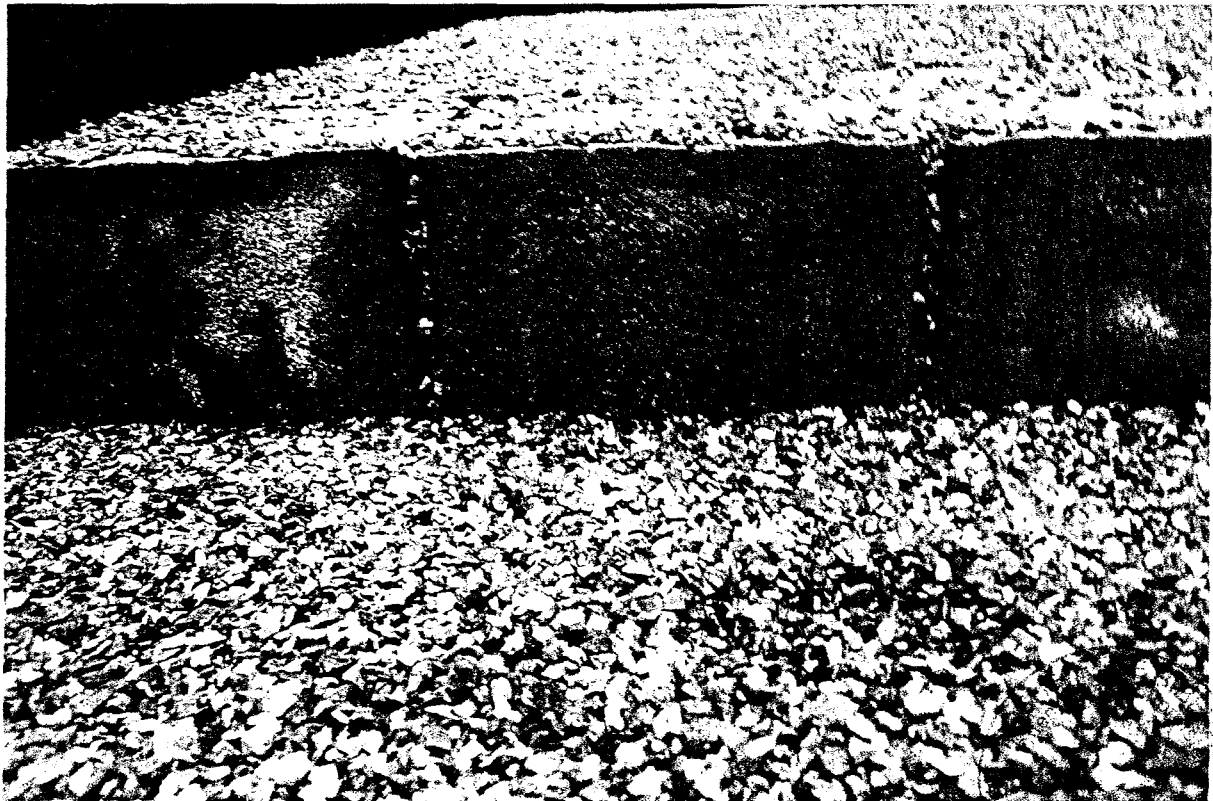
Bild 4: Detailansicht, Fuge nach Bewässerung
