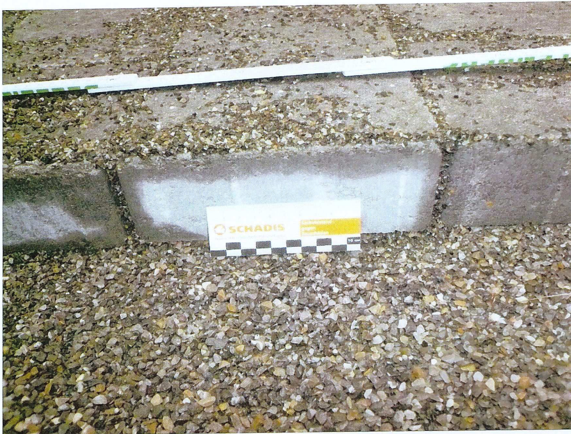
Bild 6: Detailansicht, Fuge nach Bewässerung
