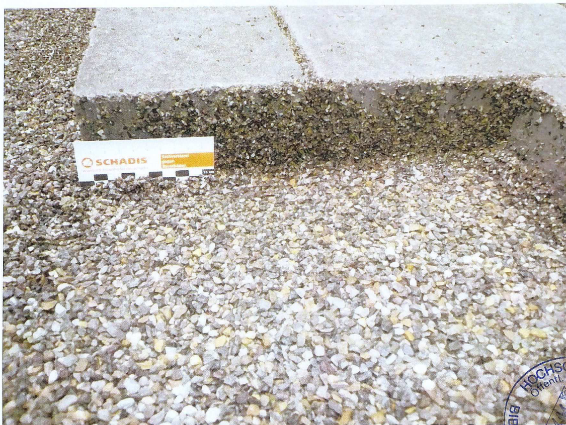
Bild 7: Detailansicht, Fuge nach Bewässerung
