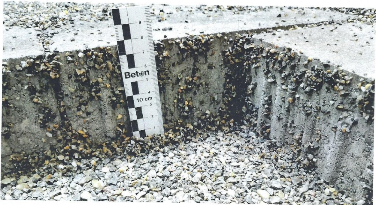
Bild 6: Detailansicht, Fuge nach Bewässerung
