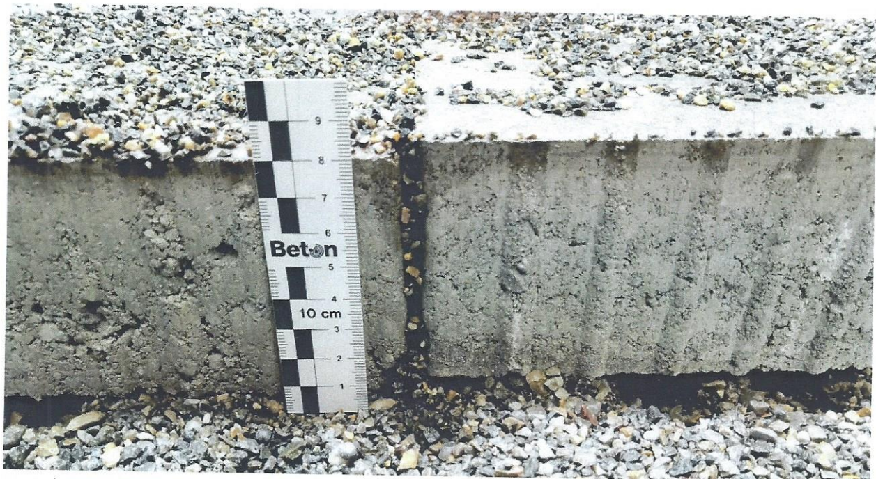
Bild 7: Detailansicht, Fuge nach Bewässerung
