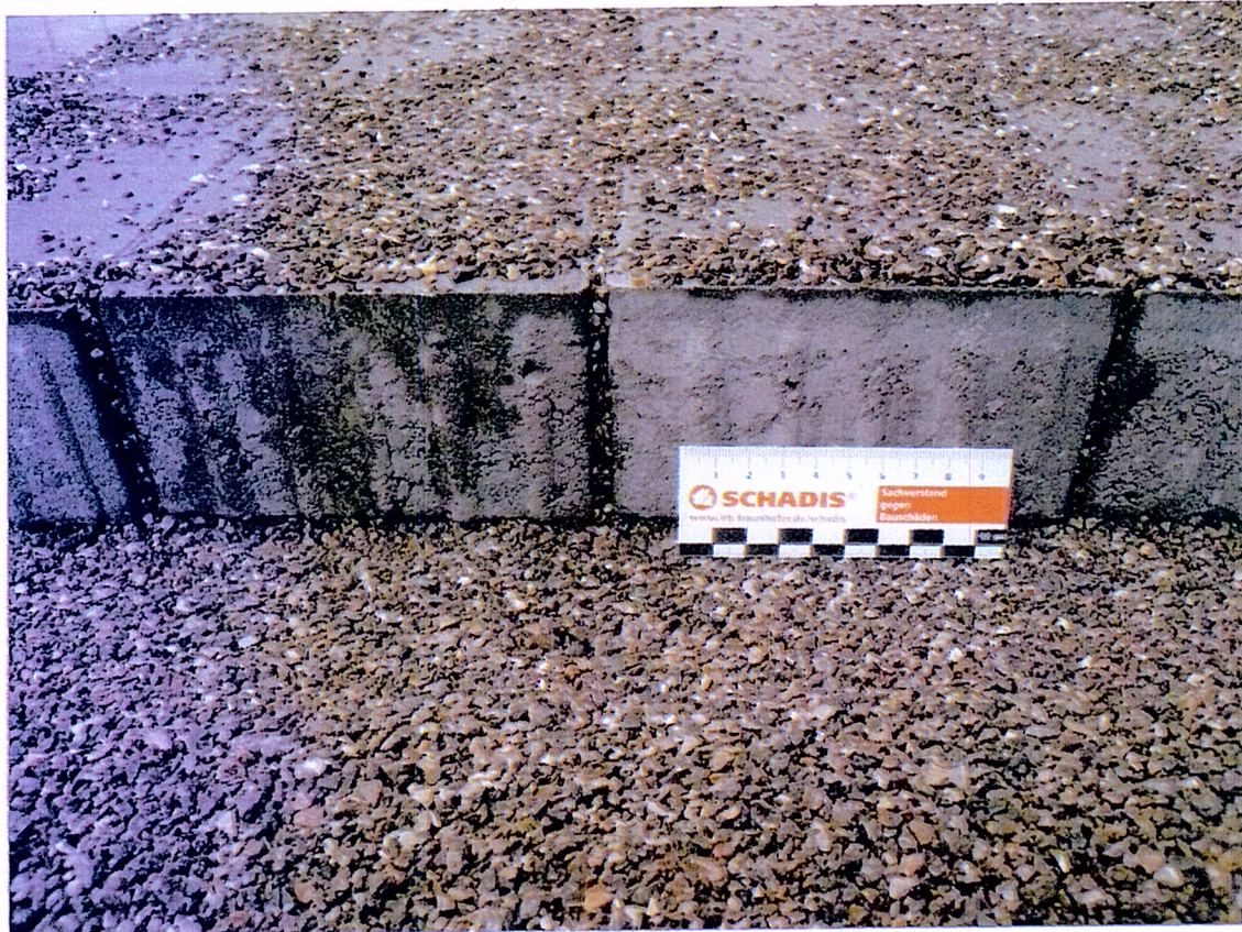
Bild 5: Detailansicht, Fuge nach Bewässerung
