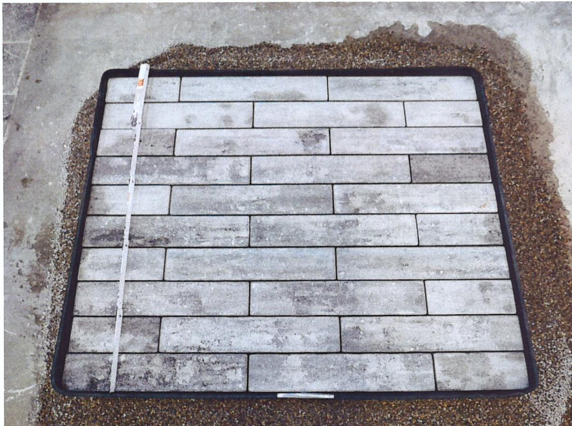
Bild 2: Vorgeschlagene Musterfläche des Betonpflastersystems „ARTLINE SLIM“ Steinhöhe 120 mm, verlegt im Läuferverband
