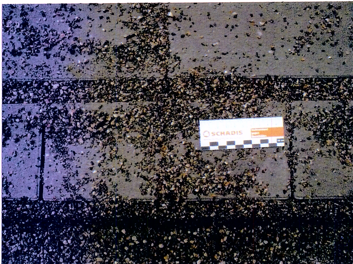
Bild 6: Detailansicht, Fuge nach Bewässerung
