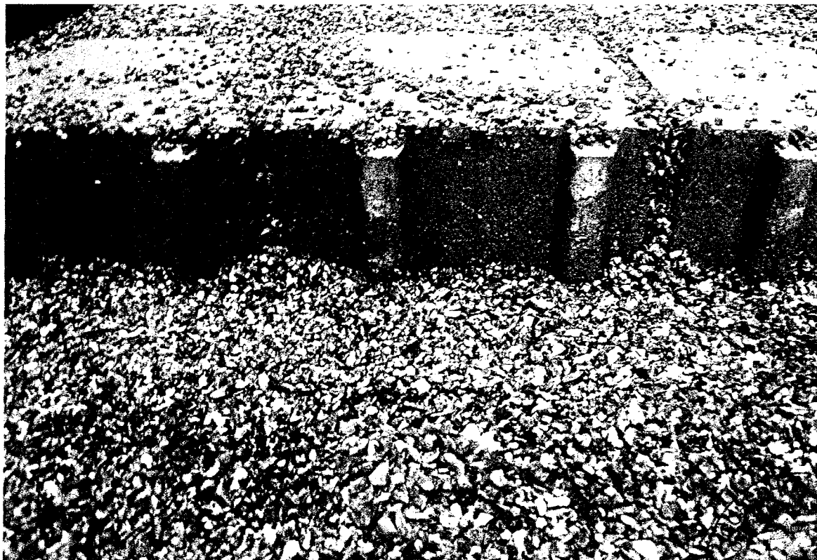
Bild 4: Detailansicht, Fuge nach Bewässerung
